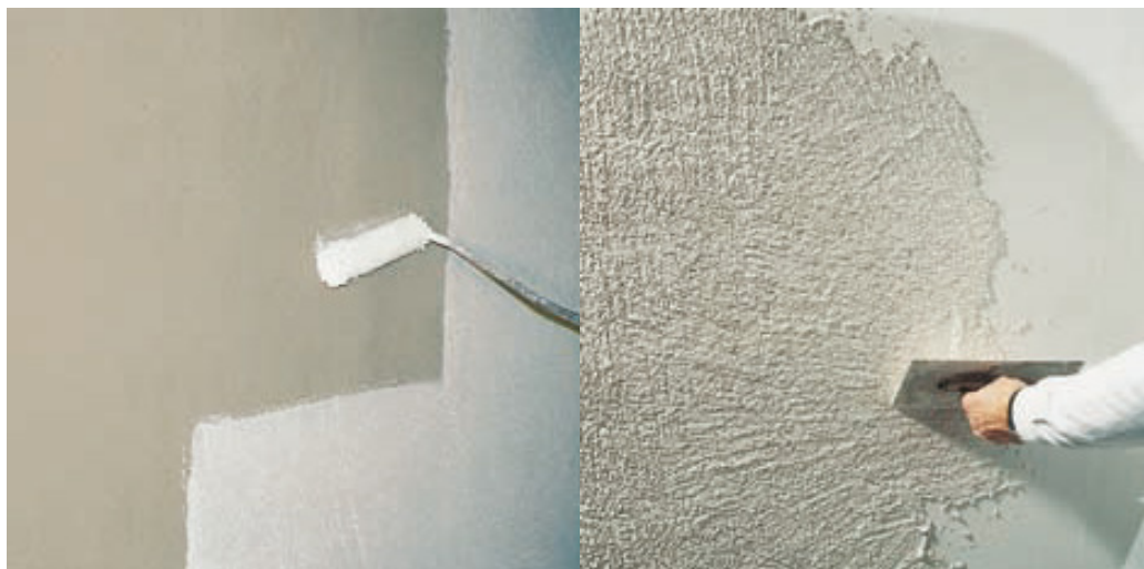
Slika 4. Nanošenje predpremaza (lijevo) i završno-dekorativne žbuke
